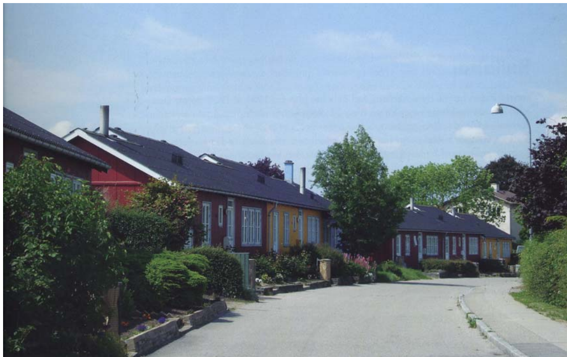
Gadeparti fra Herlevhuse. De mange grønne områder og boligernes farver gør det svært at se at bygningerne er lavet af beton (foto: SAB-bladet)
