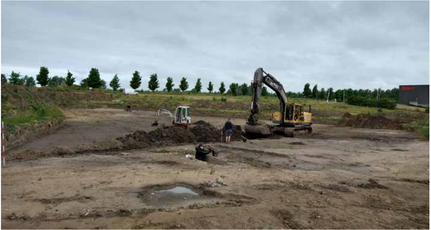
Udgravning i gang. Der anvendes alt fra store gravemaskiner til murerskeer. (Foto: Susan Pallesen)
