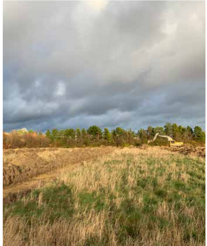
Ragnesminde. En dejlig novemberdag på prøvegravning ved Coops kommende logistikcenter i Brøndby. I baggrunden ses gravemaskinen. Det vigtigste graveredskab på en prøvegravning.
