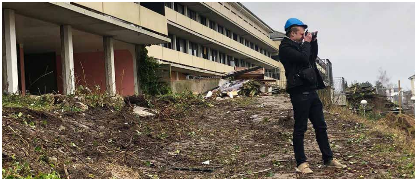
Nyere Tids-arbejdet på Kroppedal Museum handler også om aktuelle begivenheder på Vestegnen. Her er museumsinspektør Anders Dalsager i gang med at dokumentere nedrivningen og ombygningen af en del af Tåstrupgård, et vigtigt alment boligområde i Høje Tåstrup Kommune. Foto: Katrine Winther.
