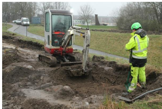
Udgravning af konstruktion 2
