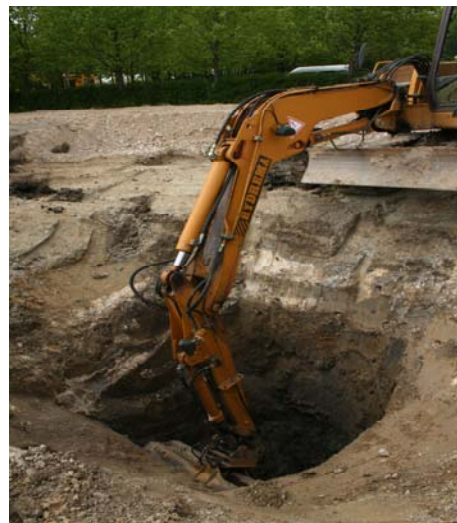
Fig. 5 Gravemaskinen under udgravning af brønd.
