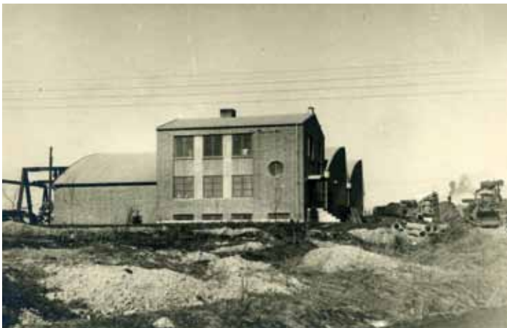
Thor Radiator under opførelse i Herlevs Industriområde I i 1949. Fabrikken voksede hurtigt og udvidede af flere omgange. Produktionen flyttede i 2002 til Belgien, mens lager og administration i 2005 flyttede til Kolding. I dag huser fabrikken bl.a. børneforlystelsesetablissementet FunCity (Herlev Kommunes Lokalarkiv).
