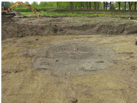
Fig. 4 – Brønden som den så ud efter muldafrømning.
