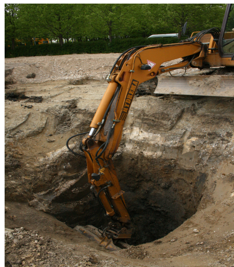
Fig. 5 Gravmaskinen under udgravning af brønd.
