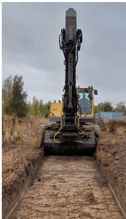
6 Afrømning af muldjorden ved Arne Madsen med en 35 tons gravemaskine på bælter og påmonteret en to meter bred rabatskovl. Foto lånt fra TAK2092. Foto: Susan Pallesen. Kroppedal Museum.
