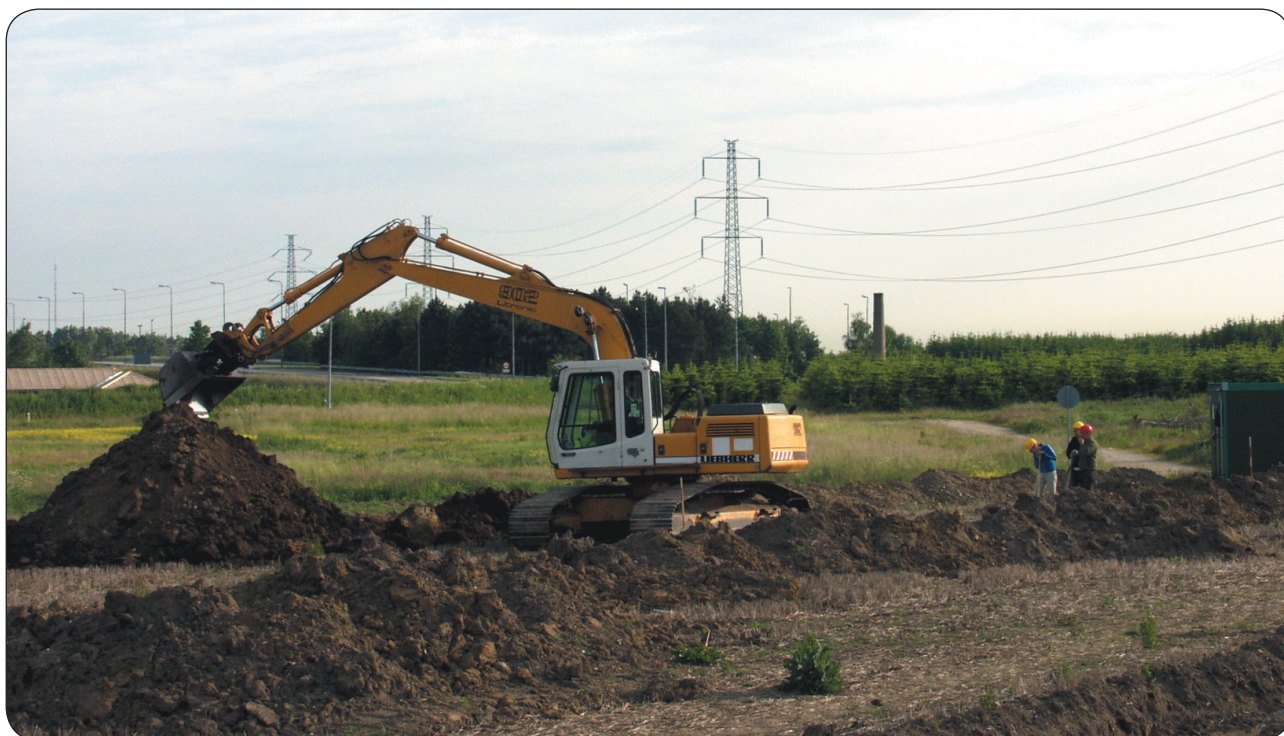
Fig. 4. Gravemaskinen udlægger søgegrøfter. Arkæologerne afsøger undergrunden for forhistoriske anlæg i umiddelbar forlængelse af afdækningen
