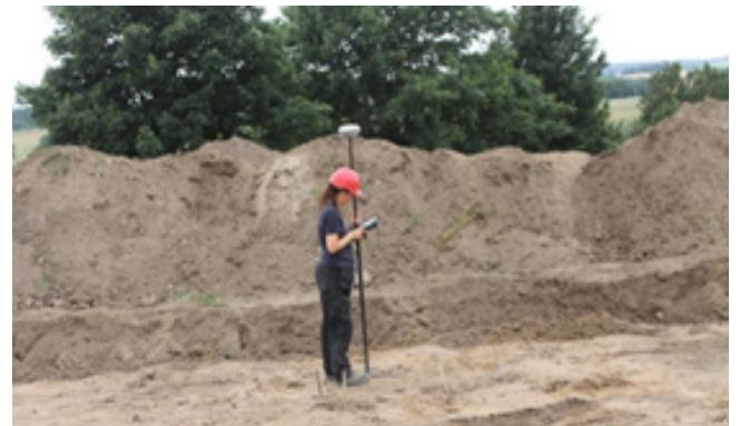
GPS-opmåling af anlæggene.
