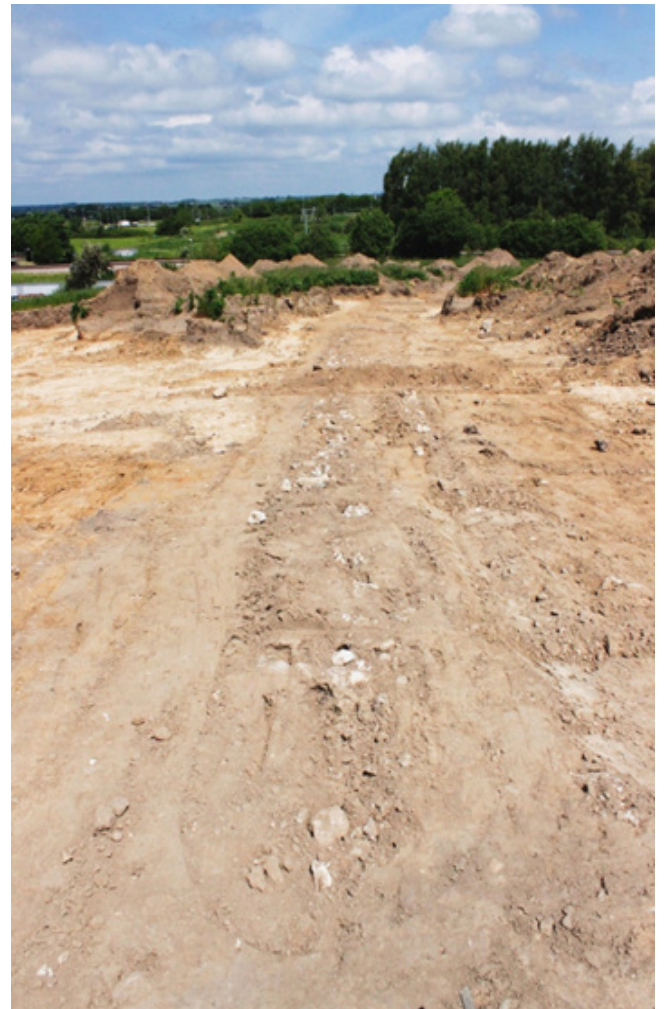
Hulvej repareret med skærver. Dette er nok et sent træk.
