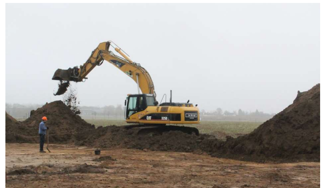
Arbejdsgang: først fjerner vi overjorden med gravemaskine...
