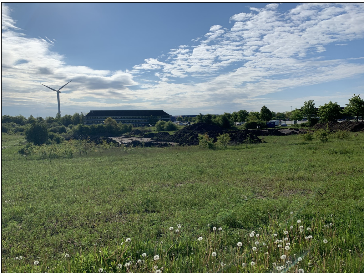
Udgravningen er godt i gang.
