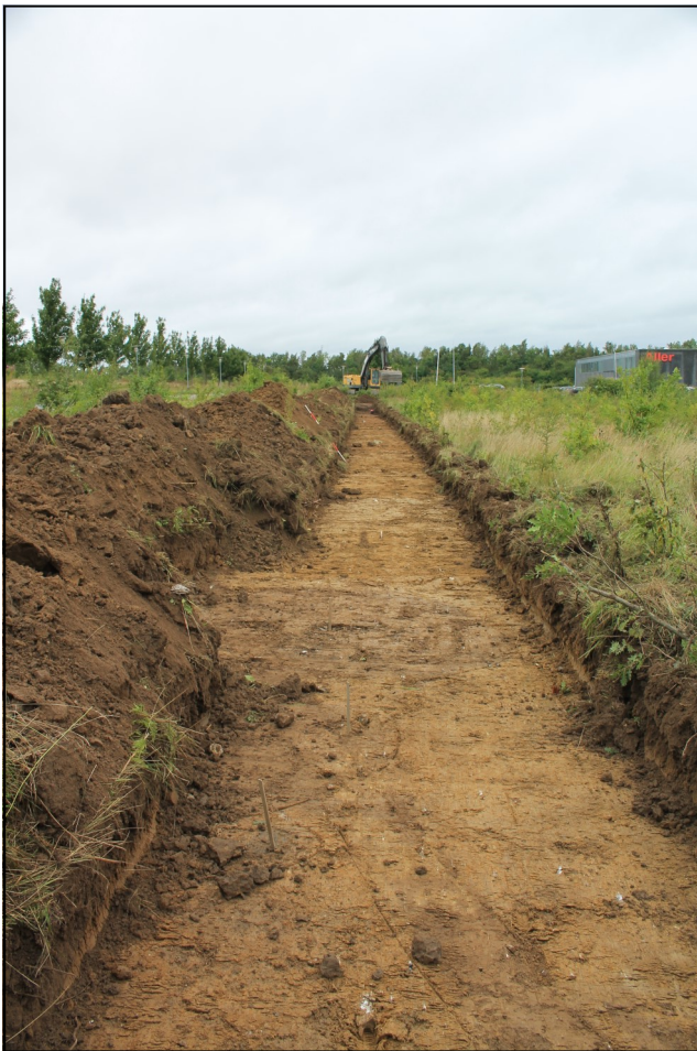
En søgegrøft fra prøvegravningen i 2020.
