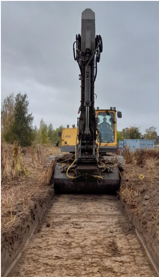
Billede 5 Afømning af muldjorden ved Arne Madsen med en 35 tons gravemaskine på bælter og påmonteret en to meter bred rabatskovl. Foto lånt fra TAK2092. Foto: Susan Pallesen. Kroppedal Museum.
