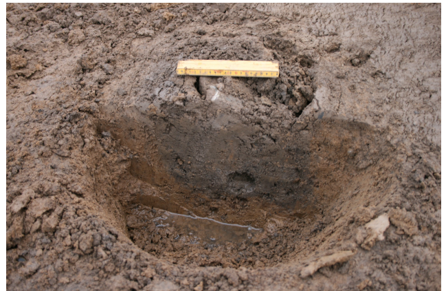
Stolpehul under udgravning
