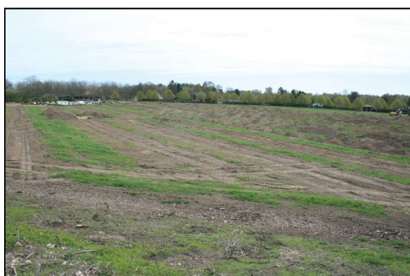
Med en gravemaskinen er der gravet søgegrøfter på arealet.
