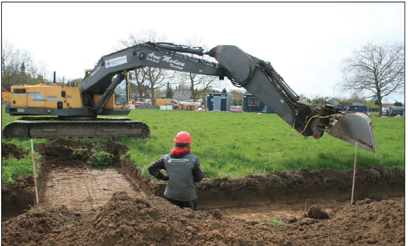
Prøvegravningen er i gang med gravemaskine.
